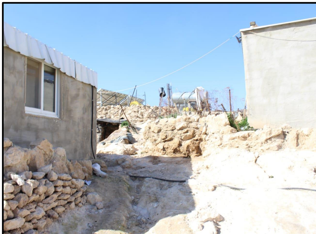
תמונה 16: חדש מול ישן – מבני אבן חדשים בין טרסות ומערות. בסמוך ניתן לראות מכלי מים, מערכת לוחות סולריים לאספקת חשמל, וכן צנרת מים לבתים (צולם ב-2 בפברואר 2019).
